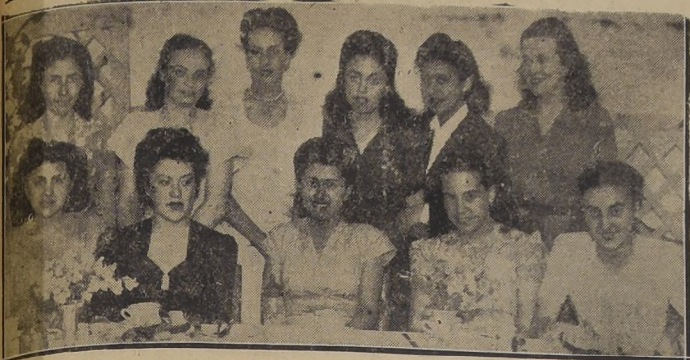
Despedida de soltera a la señorita Virginia Acosta, en los salones de los Establecimientos Oriente
