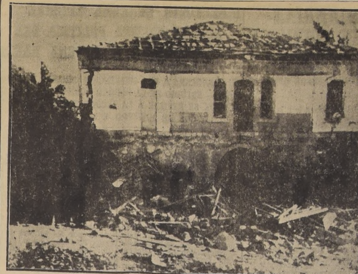
JERUSALEN. — La presente telegrafía muestra la oficina de Impuestos de esta capital, seriamente dañada después de sufrir los efectos de las bombas de tiempo colocadas por los terroristas.
