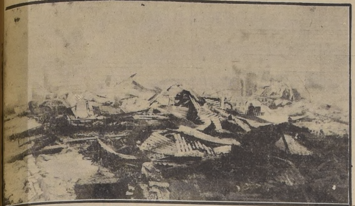
Escombros de lo que quedó reducido el establecimiento incendiado
