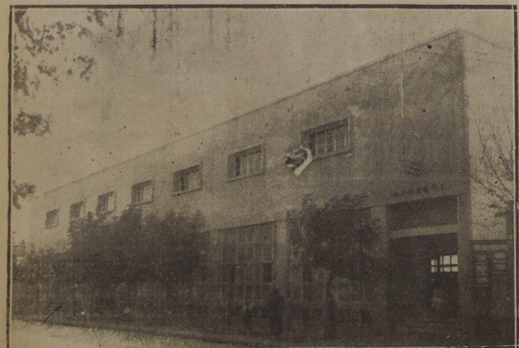
El magnífico edificio que ocupan las Oficinas del Crédito Popular en Rancagua
