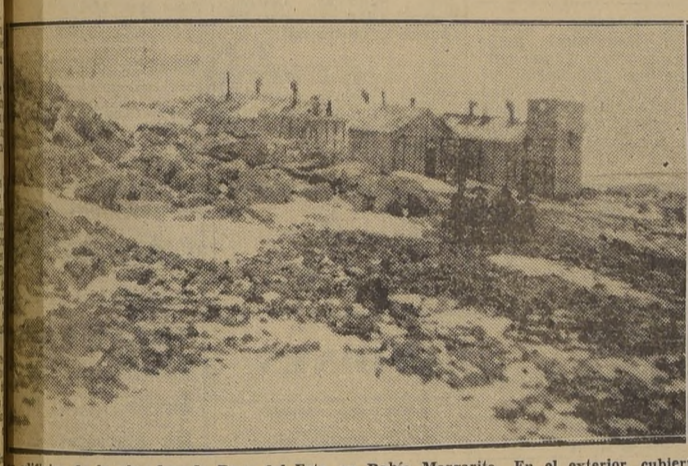
Edificios de la abandonada Base del Este en Bahía Margarita. En el exterior, cubiertos de nieve, habían un tractor y un tanque.
