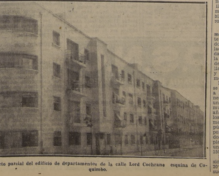
Aspecto parcial del edificio de departamentos de la calle Lord Cochran esquina de Cumming.
