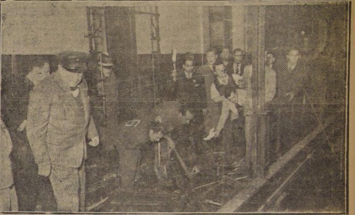
Bomberos y empleados trabajan intensamente durante el amago de incendio de ayer
