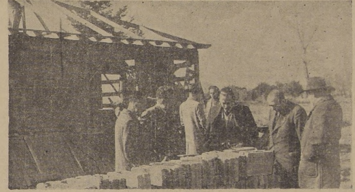
El regidor Martínez Camps e ingenieros de la Caja de Empleados Municipales, con el representante de LA NACION se imponen de las características de una casita de concreto vibrado para poblaciones de emergencia
