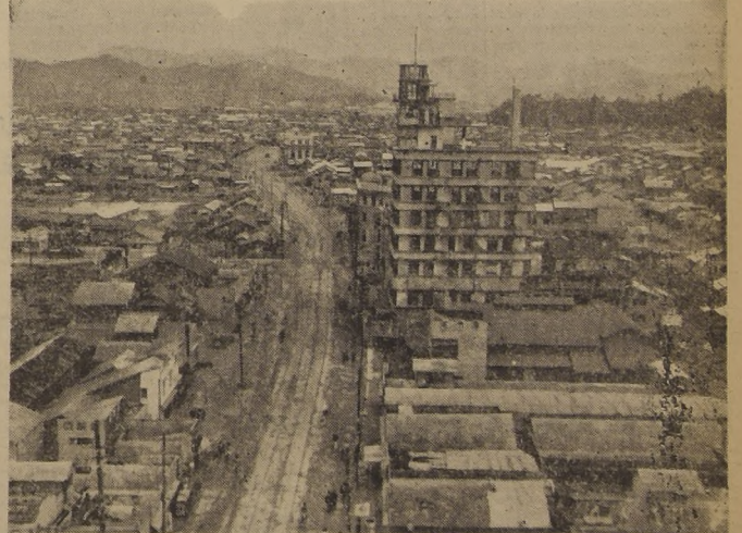
La principal calle de Hiroshima, tal como se ve hoy. Esta fotografía fue tomada desde la techumbre del edificio de departamentos Fu yuka. El edificio de la derecha al centro, es el de la Prensa Chuguko, que soportó la explosión.—(Foto ACME exclusiva).
