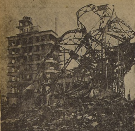
El edificio de la Prensa Chugoku, en la calle principal de Hiroshima, poco después de la explosión atómica. Este edificio soportó la enorme fuerza de la explosión, pero su interior quedó totalmente destruido. — (Foto ACME exclusiva).
