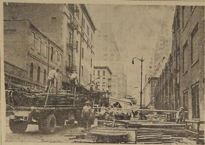
Vista de la calle 45 de la ciudad de Nueva York, que muestra la demolición de los edificios en el sitio que ocupará la sede permanente de las Naciones Unidas. Se estima que este trabajo inicial se demorará unos cuatro meses. — Nueva York, 23 de julio de 1947. — (Fotografía oficial de las Naciones Unidas, Departamento de Información Pública).
