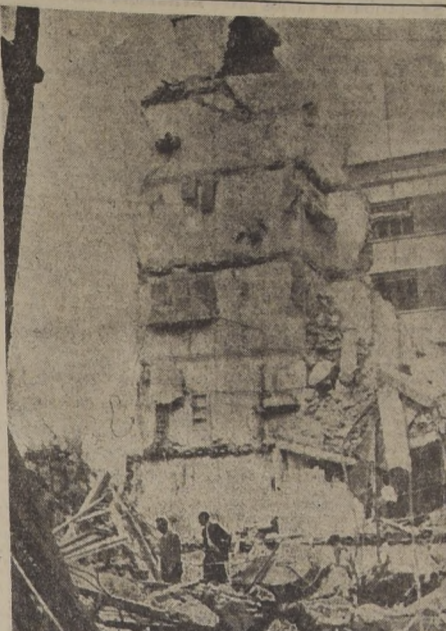
MILN (Italia).—Vista de la tienda "Rinascente", de Milán, de seis pisos, después que se derrumbó, dando muerte a 15 personas e hiriendo a 25, cuatro de ellas de gravedad.— (Foto ACME).
