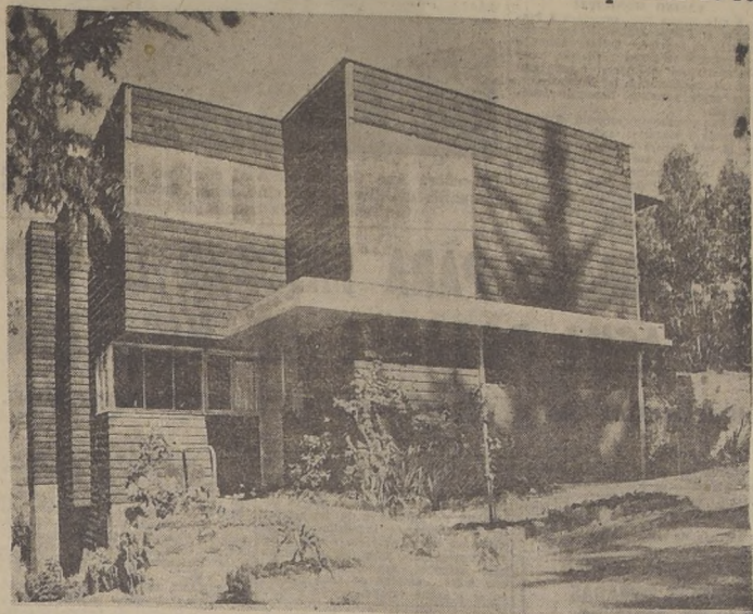
Vista de las fachadas norte y oeste. Ventanas metálicas, sofitos recubiertos con aluminio e contraste con la madera de los muros.
