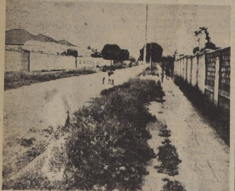
Aspecto de la calle Jorge Luco, de La Cisterna, que carece de agua potable, afectando a cinco mil personas
