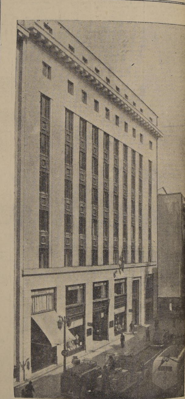
Las bandejas, gradas y pastelones vibrados de este edificio ubicado en Alameda al Megar a la Plaza de Armas, propiedad del Banco Hipotecario de Chile, han sido fabricados y colocados por
