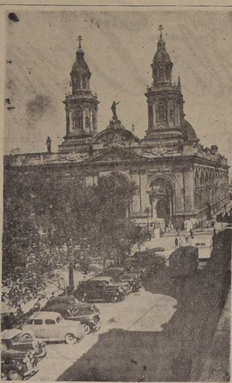
PLAZA DE ARMAS.— Nuestra vieja plaza necesita remozarse. Faltan bancos. Falta sombra. Sus árboles han envejecido prematuramente. Los gorriones han invadido los gruesos troncos carcomidos y constituyen una molestia constante. Debieran ser exterminados por inútiles y sucios
