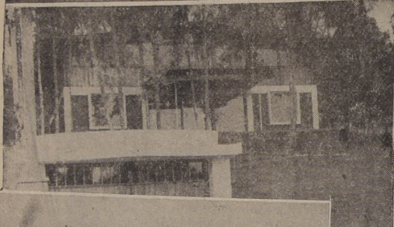
EN SANTO DOMINGO: interesante casa habitación de propiedad del doctor don René García Valenzuela. — Arquitecto, don Fernando López
