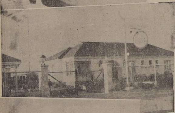
EN MAIPU: planta de la Standard Oil Co. Oficinas y portería. — Arquitecto, don Jaime Rodríguez
