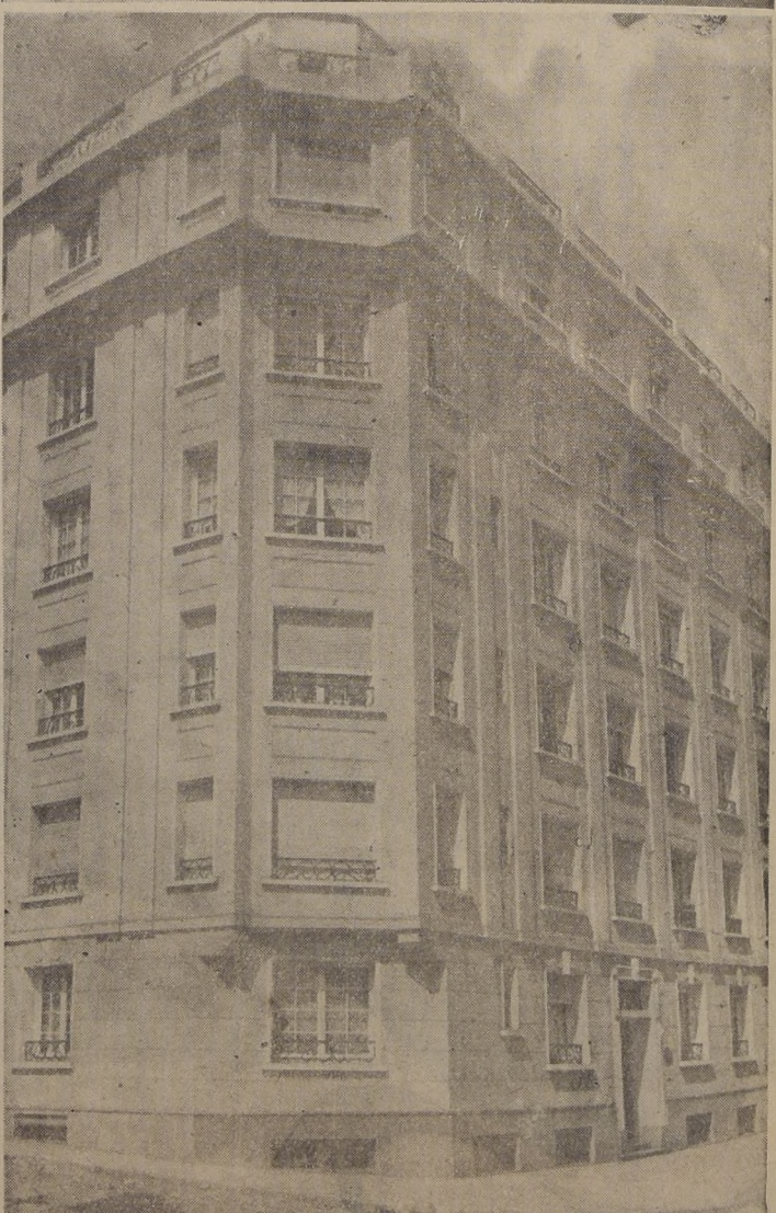
DOS ASPECTOS DE ESTE MODERNO EDIFICIO, UBICADO EN CALLE MIRAFLORES.— ARQUITECTO DON MATEO HOMAR
