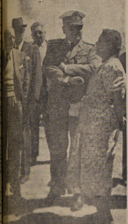
Director de Obras Públicas, don Ernesto Merino, acompañado por el ingeniero Puñco y algunos miembros de su comitiva conversan con los obreros de la frontera con Argentina, con una cantinera de las obras de construcción del Ferrocarril de Antofagasta a Salta.
