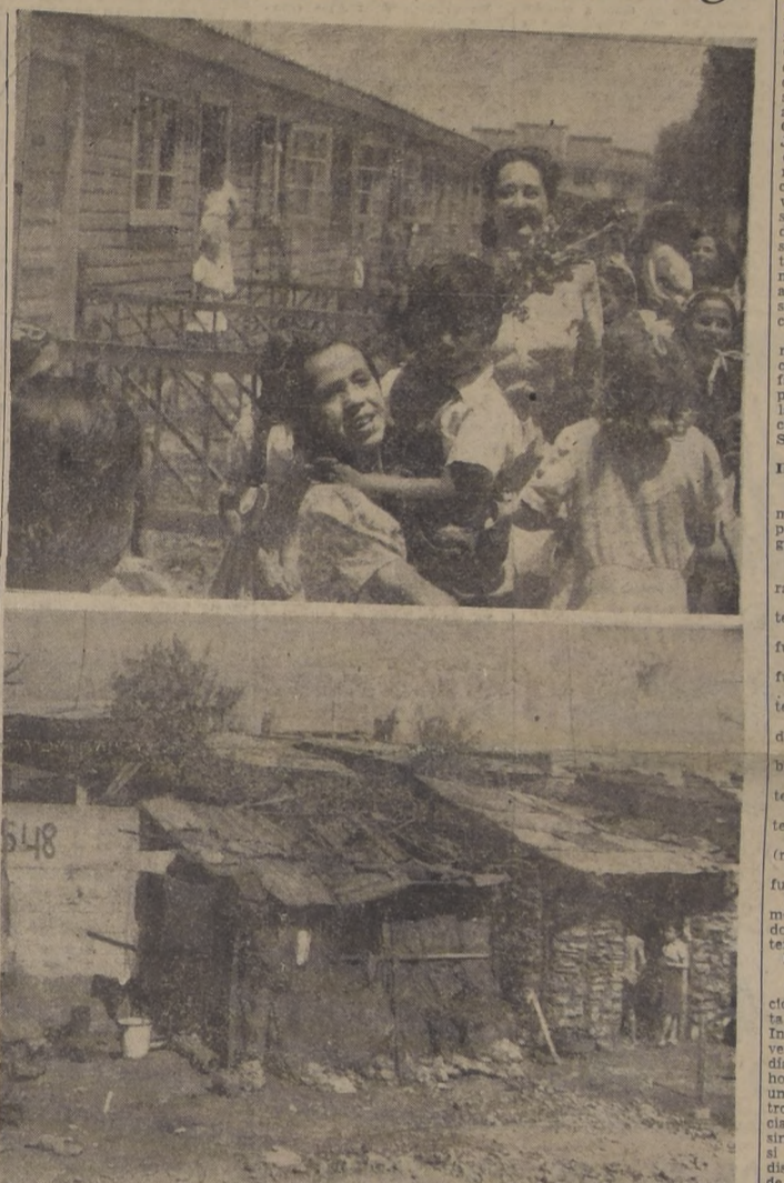
El contraste que ofrecen estas dos fotografías es la demostración más concluyente de los beneficios que para el obrero ha significado la iniciativa del Presidente de la República de construir casas de emergencia. — Arriba se ve una parte de las casitas de la calle Conferencia, donde las mujeres y los niños rodean a la Visitadora Social de la Presidencia, señora Adriana Daroch de Vergara. — Abajo, un rancho del Zanjón, de la Aguada, donde hace dos meses vivía una de las familias que ahora disfrutan de una vivienda confortable en la población “Gabriel González Videla”.
