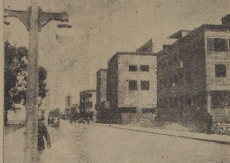
Por el lado suroccidental de la Plaza, puede verse a la derecha, el moderno edificio de la Caja Nacional de Ahorros y más allá una construcción que está sin terminar, como muchas otras en toda la ciudad.
