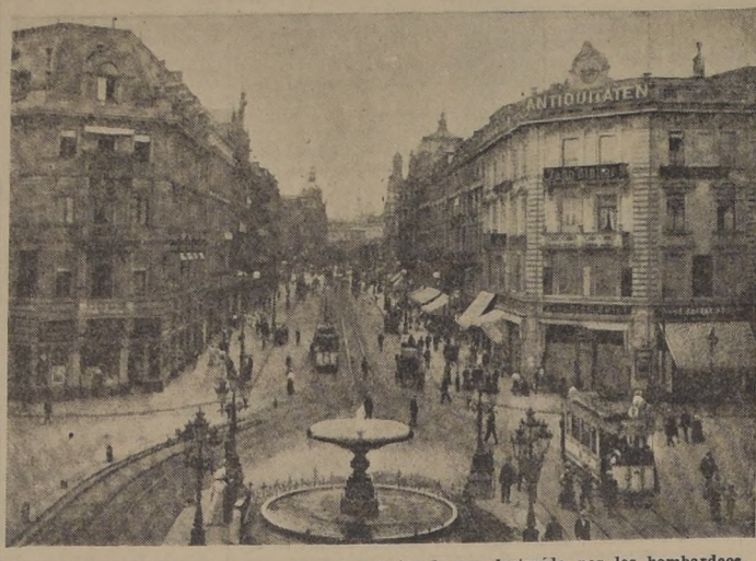
Una de las principales calles de Francfort antes de ser destruida por los bombardeos. Los aliados proyectan la reconstrucción de la gran ciudad del Main, para hacerla la sede del Gobierno de Alemania Occidental.
