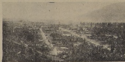
Aspecto panorámico de la ciudad de La Ligua
