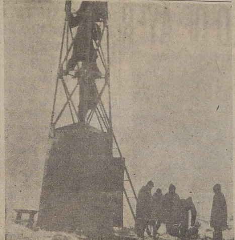
El primer faro construido en la Antártida, y que lleva el nombre de Prat.— El grabado muestra a los marineros chilenos durante las pesadas faenas de su construcción, que estuvieron a cargo del subteniente don Marcos Ortíz
