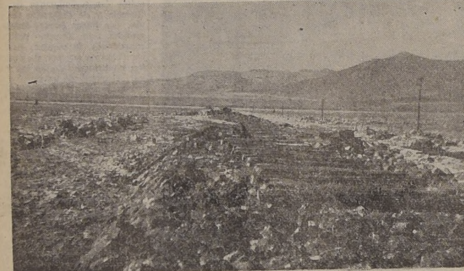
Colocando durmientes en el sector Pocitas
