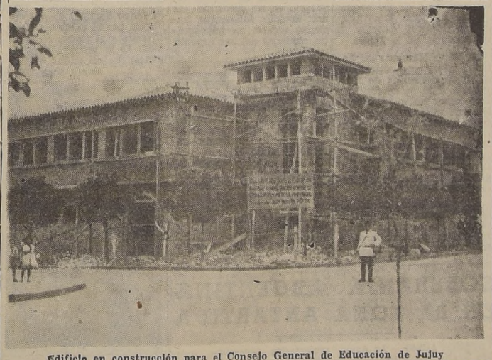
Edificio en construcción para el Consejo General de Educación de Jujuy
