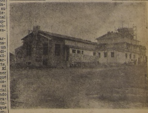
Edificio en construcción del Hotel de Turismo en Alto de la Viña.
