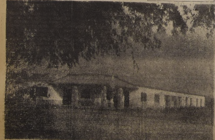
Edificio de la Comisión y Sala de Primeros Auxilios en Paipalí.
