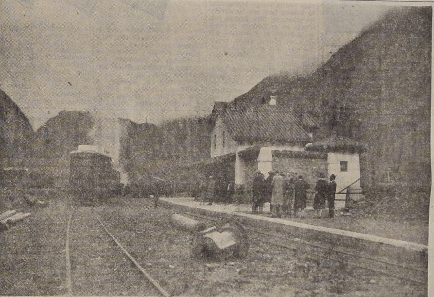
Larga y laboriosa fué la construcción del tramo Salta-So compa en el lado argentino. En estos grabados pueden apreciarse algunos aspectos de las obras. En esta foto la ESTACION TASTIL.
