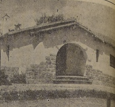
Edificio de las oficinas públicas en el Perico de San Juan. Sala de Primeros Auxilios en Perico de San Juan.
