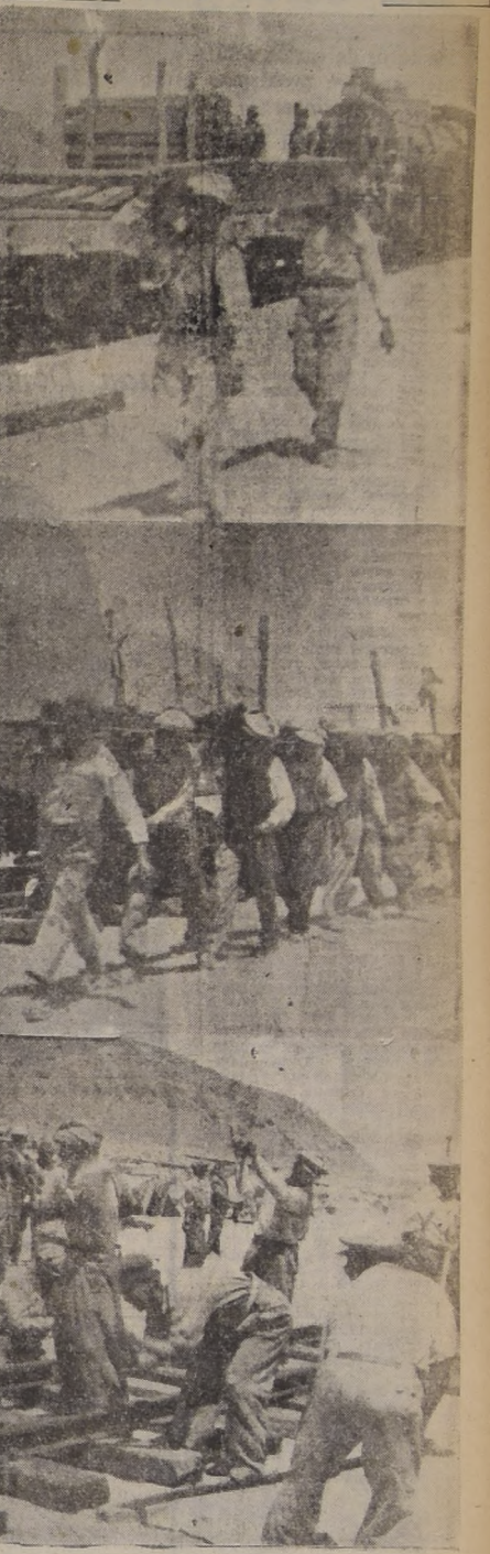
En estas fotografías puede observarse a un grupo de 17 obreros argentinos que procedieron a transportar y colocar los últimos rieles. Arriba, dos obreros transportan un durmiente; en seguida, 17 obreros toman "al hombro" el último riel, de 10 metros de longitud y 350 kilos de peso y lo levantan hasta el sitio de la unión, y finalmente abajo, proceden a colocarlo y remacharlo con los clavos de rigor.
