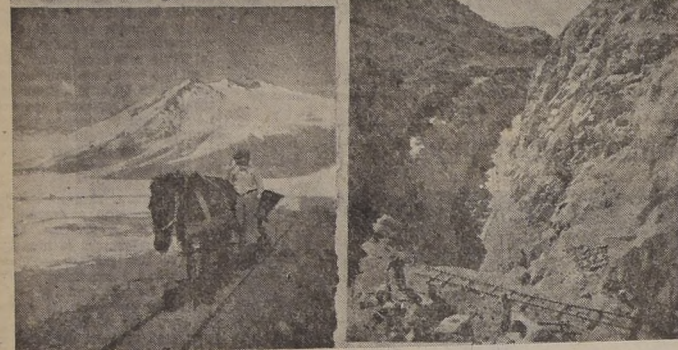
De izquierda a derecha, arriba: La nueva vía entre las estaciones Alcalde Poblete y Adolfo Zaldívar, y uno de los lujosos automotores que harán el servicio en el lado chileno. ABAJO, un obrero trabajando en el lado chileno. Al fondo se divisa el volcán Socompa, y el Corte de Taca-Taca en el lado argentino.
