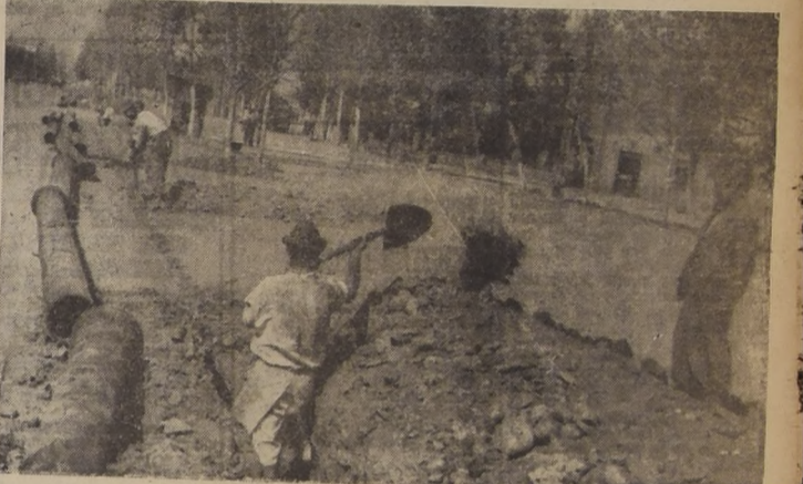
Un aspecto de los trabajos de cambio de matrices en la Alameda O'Higgins, desde General Velásquez hasta Amengual, que permitirán una mejor dotación de agua potable a las miles de personas que viven en este populoso sector poniente de Santiago.
