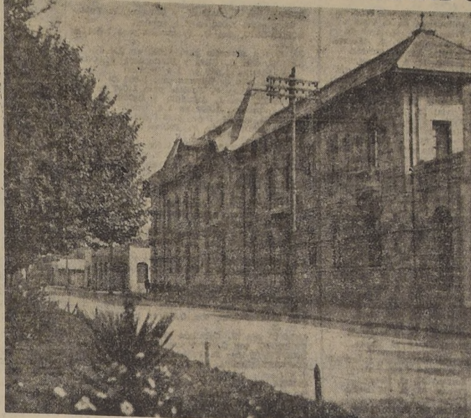
El edificio de la Intendencia de Colchagua, frente a la Plaza
