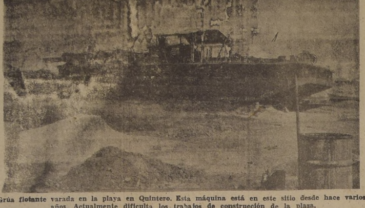
Grúa flotante varada en la playa en Quintero. Esta máquina está en este sitio desde hace varios años. Actualmente dificulta los trabajos de construcción de la plaza.
