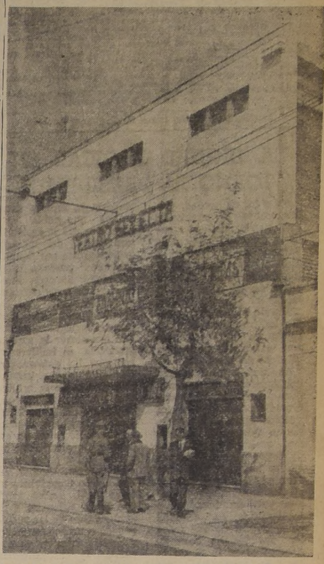
Frontis del Teatro "Selecta" que fue afectado el viernes por un desplome del techo, causando muertos y heridos. — En visita efectuada ayer por LA NACION acompañando al regidor señor Ugarte Salazar, pudo imponerse que en la noche del sábado se produjo un nuevo derrumbe de un sector del techo, lo que evidencia aun más las precarias condiciones de seguridad de este cine. — El Alcalde de Santiago ha dispuesto una estricta revisión de todas las salas de espectáculos de la capital, para prevenir futuros desastres, como el ocurrido el viernes y al mismo tiempo ha ordenado la substanciación de un sumario para deslindar las responsabilidades del caso, por el trágico accidente del "Selecta" el que será iniciado hoy.
