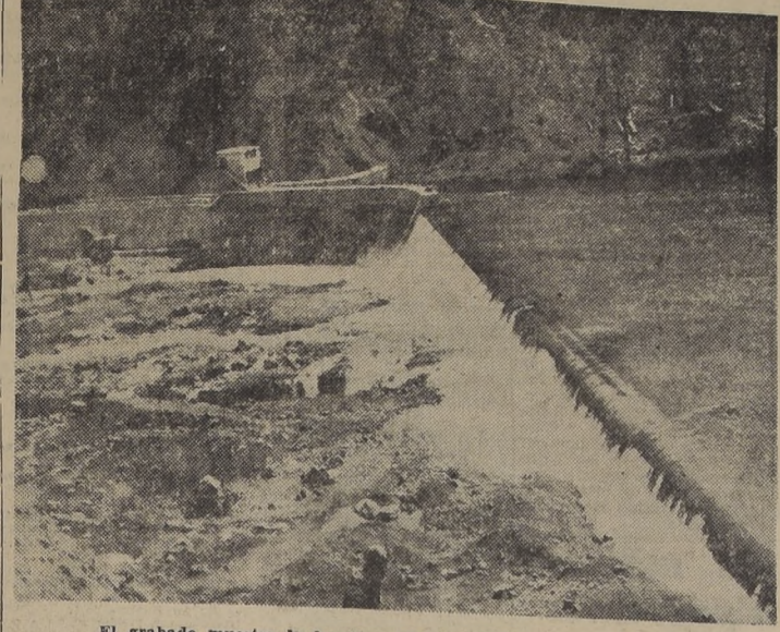
El grabado muestra la bocATOMA de la planta "El Abanico".
