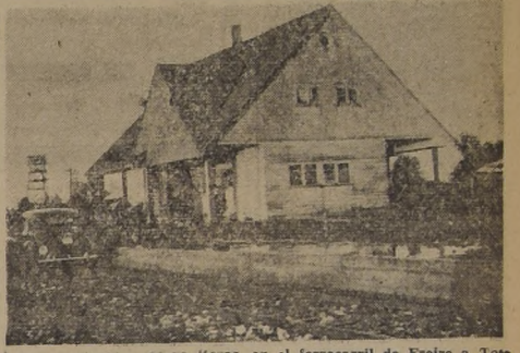
Alarma ha causado en toda la zona la paralización de la obra en el último tramo.
