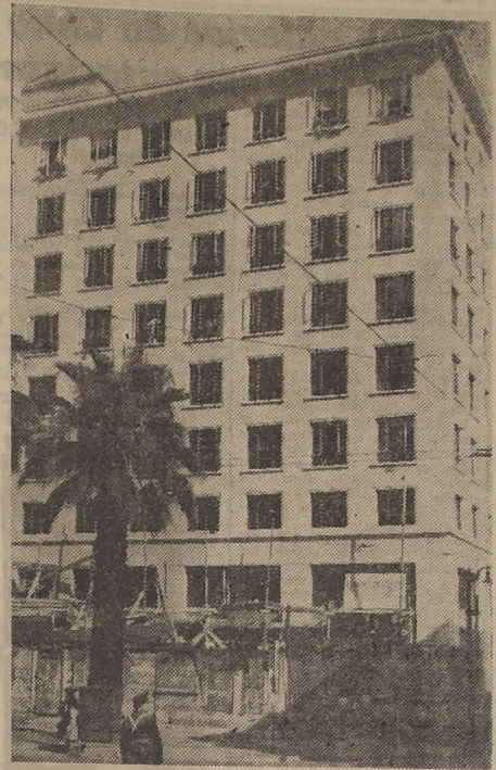
Aspecto exterior del edificio de los señores Barros, Opazo y Cia.
