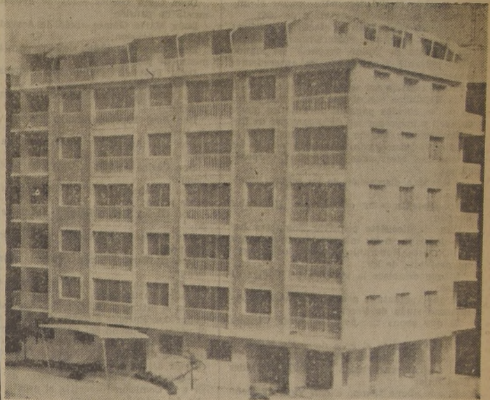
Un aspecto del nuevo y moderno edificio de locales comerciales y Departamentos, cuya construcción cambia totalmente el aspecto de la calle Mapocho entre Estado y San Antonio
