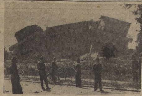
BERLÍN.— El último refugio de concreto y acero que quedaba en pie en Berlín, en el Tiergarten, fue volado por ingenieros británicos. — (Foto ACME.).
