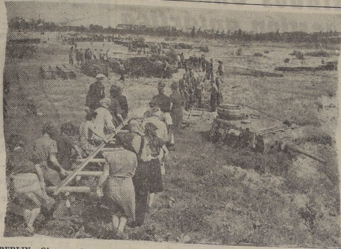
BERLIN.—Obreras alemanas ayudan a tender líneas decauville mientras se apresura la construcción de un nuevo puerto aéreo en Berlín en la zona francesa, que permitirá un mayor envío de provisiones de boca para los habitantes de la capital de Alemania que se hallan bloqueados por los rusos. —(Foto ACME).
