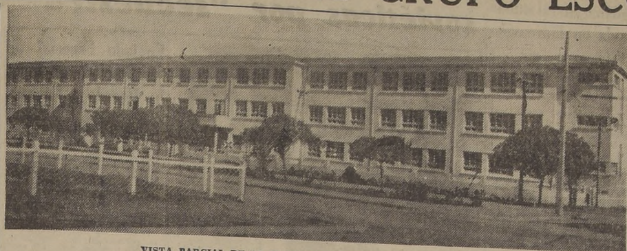
VISTA PARCIAL DE LA FACHADA DEL GRUPO ESCOLAR DE BARRANCAS
