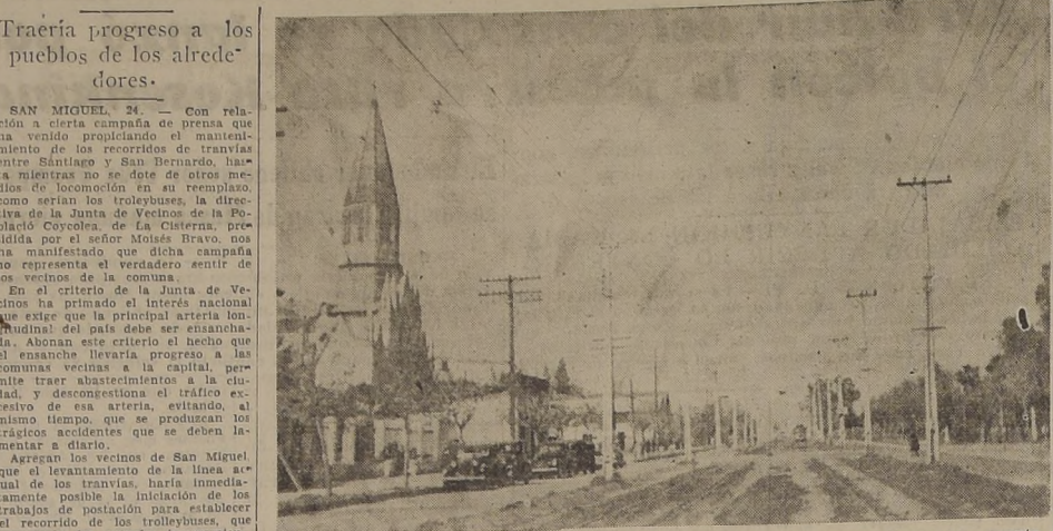
Vista de la Gran Avenida frente a la comuna de San Miguel, cuyos vecinos desean que cuanto antes se inicien los trabajos de ensanche, levantando las líneas de tranvías.
