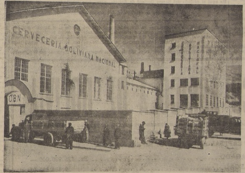
VISTA DE LAS NUEVAS INSTALACIONES
