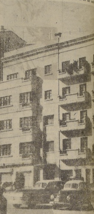
DIFUNDO RESIDENCIAL en la Avenida Mariscal.
