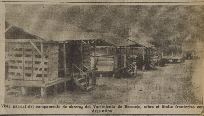
Vista parcial del campamento de obreros del Yacimiento de Bermejo, sobre el límite fronterizo con Argentina.
