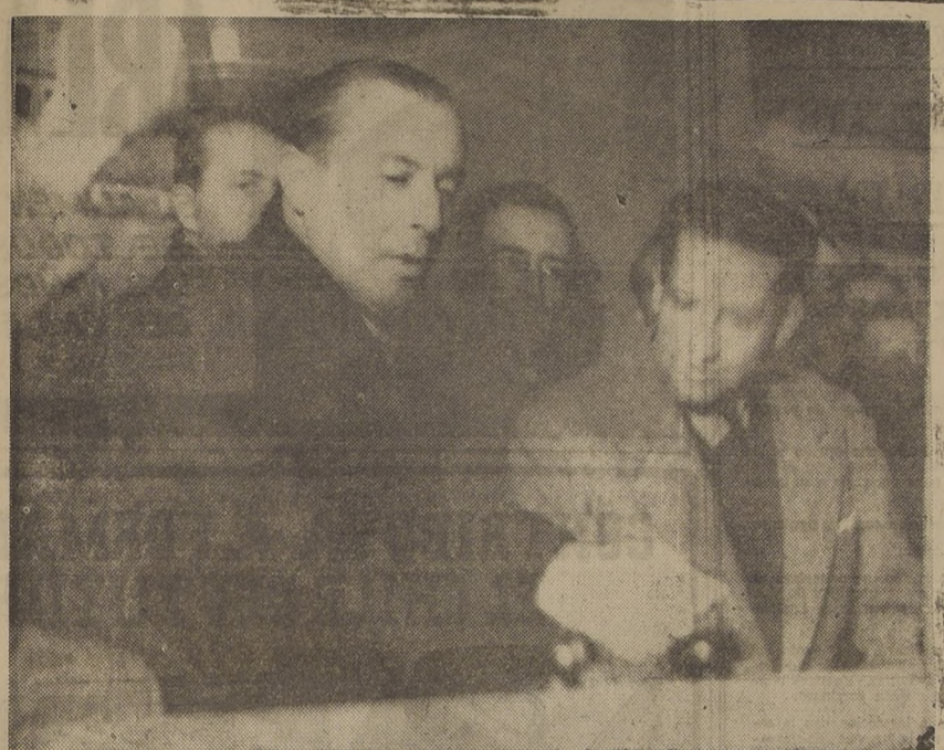
El Excmo. señor González Videla, en el momento de poner en movimiento la planta hidroeléctrica de Sauzal.
