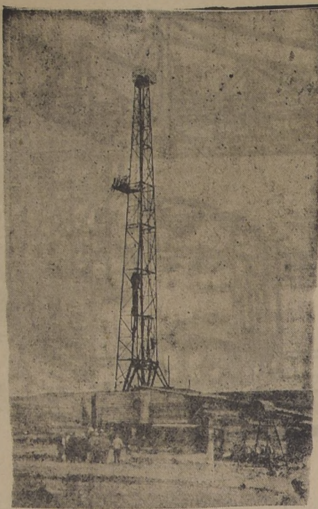
Pozo N.º 1, de Cerro Manantiales. Cerca de este lugar ocurrió el incendio.
