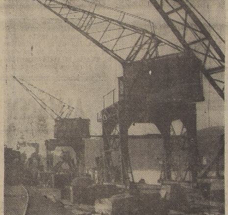
Un aspecto de la subsección "Espigones", donde se puede ver algunas grúas eléctricas para el servicio de embarque y desembarque.
