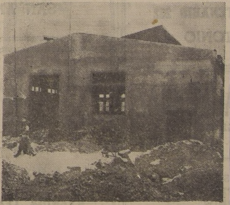
Aspecto exterior del Matadero, actualmente en construcción.
