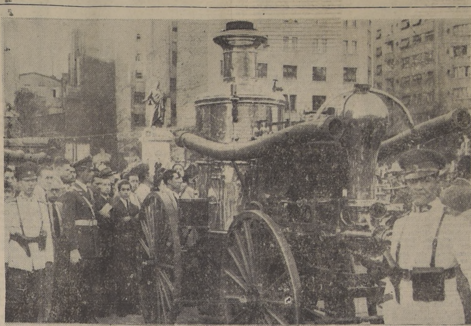
Un año después del incendio de la Compañía, esta catástrofe impuso la necesidad de establecer una sólida defensa contra los incendios, y, creado el Cuerpo de Bomberos, Chile adquirió en Estados Unidos los carros bombas más eficientes de ese tiempo. Uno de estos carros, accionado a vapor y tirado por caballos, se exhibe en el Museo del Tránsito. — El aspirante de la Escuela de Carabineros señor Héctor Campos Vergara aparece en el grabado dando a conocer al público los antecedentes históricos y otros datos de esta valiosa reliquia
