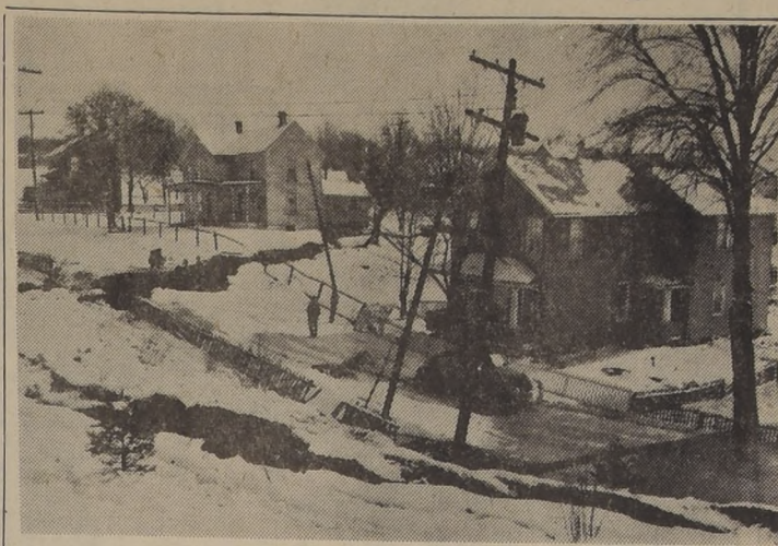
CARBONDALE, PENNSILVANIA.— Una de las calles del pueblo minero de Carbondale se hundió 20 pies, afectando a toda una manzana y remediando a las vecinas, el 1.º de febrero, debido a un derrumbe habido en una mina de antracita, el cual dejó cuatro personas heridas. Unas 14 casas quedaron dañadas en el pueblo.— (Foto ACME)
