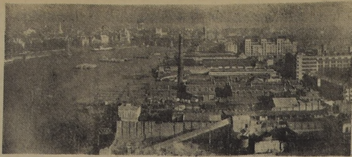
Festival británico de 1951. — Este es un aspecto de la Ribera Sur del Río Támesis, en Londres, cerca del puente de Waterloo, donde se están iniciando las obras para preparar el gran festival británico de 1951. Es el sitio donde se observa el mejor panorama de la capital británica. (Foto BIPPA).
