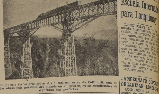
El puente ferroviario sobre el río Malleco, cerca de Collipulli, una de las obras más notables del mundo en su género, cuyas condiciones de seguridad son perfectas
