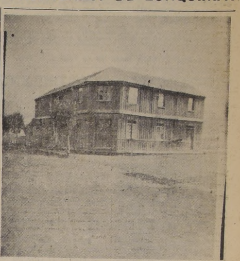
En este edificio ubicado en Villa Portales, comuna de Lonquimay, será instalado el "Internado González Videla", para los hijos de los campesinos de dicha región.
