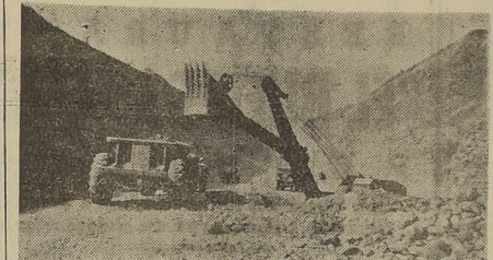
CORTE EN SALALA.—En el grabado puede verse el carguío de material en este tramo de la carretera panamericana.
