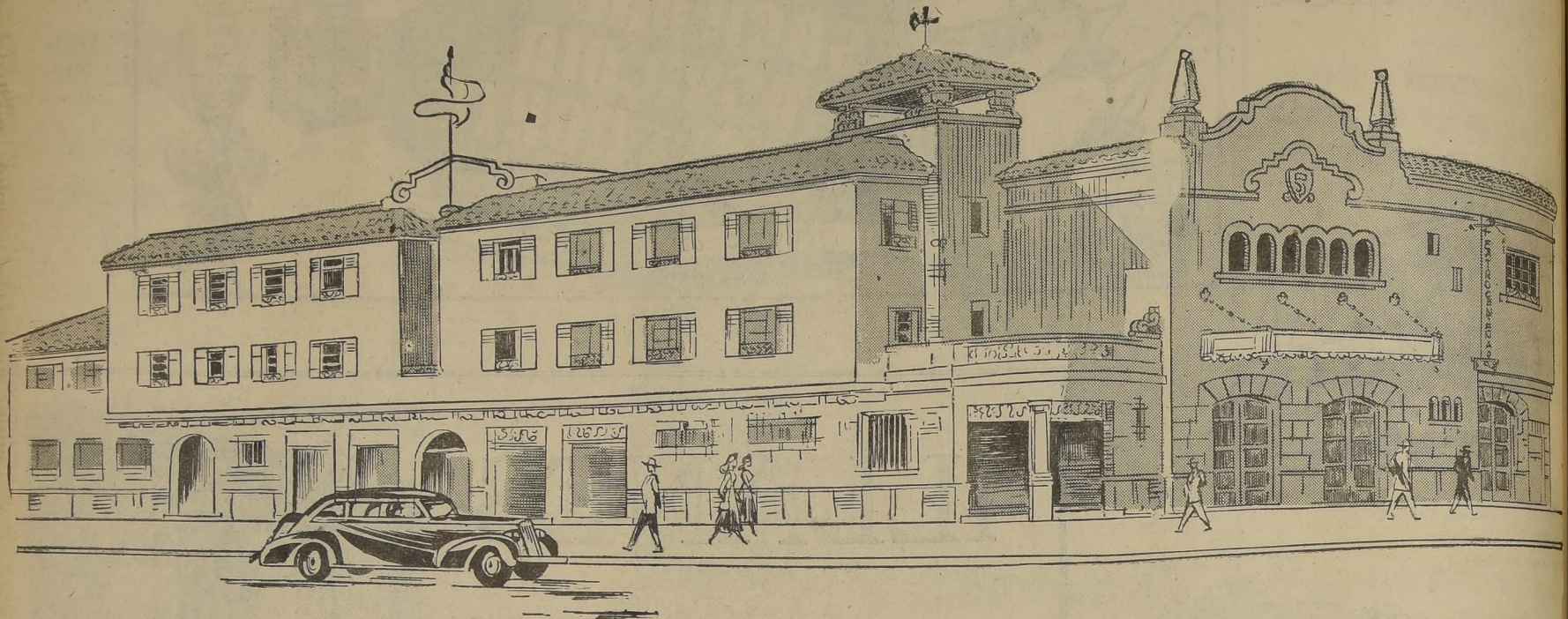
Esquina de las calles Cordovez y Carrera, donde se está construyendo el Teatro Centenario y edificio de rentas.
