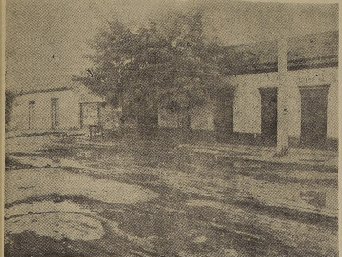
Este lodazal se extiende a lo largo de toda la calle Santa Geneveva, en la comuna de Quinta Normal. Está ubicada en la cuadra 4500 de San Pablo. Al fondo hay un puesto de frutas, y para llegar a él, los vecinos tienen que atravesar el barro. Para el mejor estado sanitario y aspecto de población, sería conveniente la intervención municipal. Hay que subsanar estas deficiencias que se observan a cada paso en la comuna de Quinta Normal.
