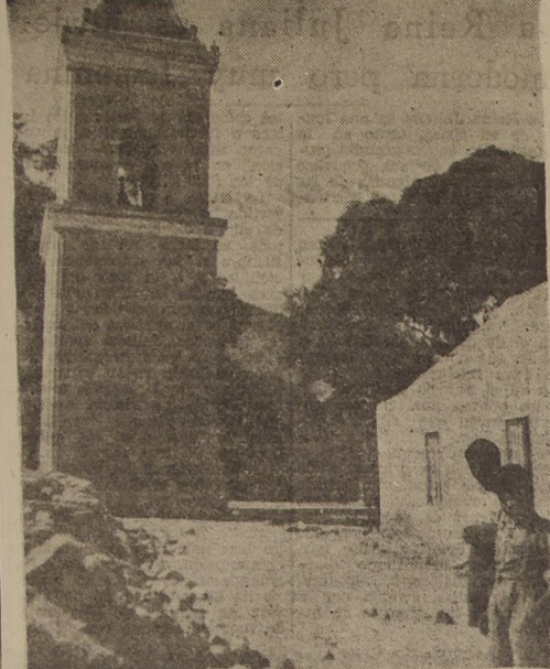
La histórica iglesia de Tarapacá, que resultó gravemente dañada como consecuencia del sismo ocurrido el lunes en la zona norte.
