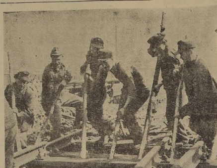
BERLIN. — Estos obreros reparan rieles de un cambio en la Estación Grunewald, para dejar las vías expeditas en cuanto el 12 de mayo se dé el orden de suspender el bloqueo de Berlín y comienz...
