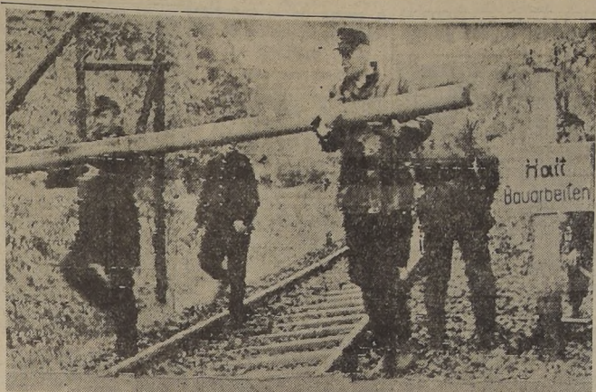
Obreros alemanes de la zona rusa alzan las barreras que bloqueaban las líneas ferroviarias que conducían a la ex capital alemana
