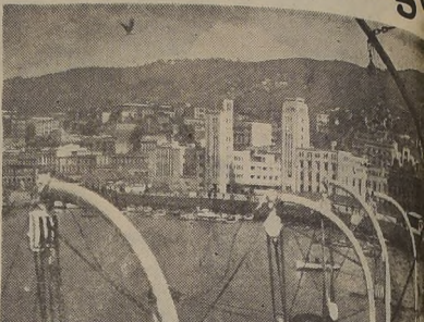
Las obras del puerto aun están inconclusas, y Valparaíso espera su terminación, como único medio de obtener una bahía segura.
