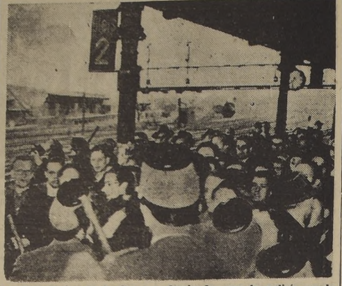
Los ferroviarios en huelga son dominados por la policía en la estación de Tempelhoff, en el sector norteamericano de Berlín.
