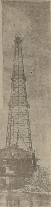
Equipo perforador, montado en una barcaza, que se considera el más poderoso del mundo. Se usó en Luisiana para excavar pozos de cinco mil quinientos metros en la tierra que se encuentra debajo del agua.
