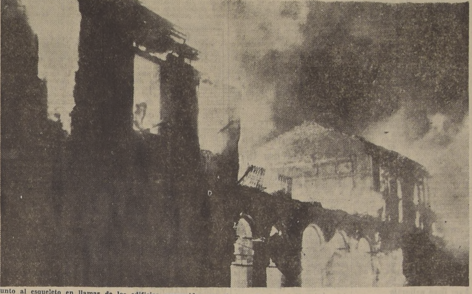
Junto al esqueleto en llamas de los edificios consumidos por el incendio que asoló en Concepción un grupo de edificios centrales, el objetivo del fotógrafo capta toda la dantesca visión de los derrumbes. En esta hoguera perecieron dos personas y un bombero que rindió su vida a la excelsa misión de servir. (Fotografía por gentileza del diario "La Patria", de Concepción)
