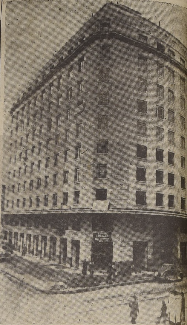
Aspecto que ofrece, actualmente, el nuevo y magnífico edificio que se está terminando por la firma Tinoco, Deves y Cía. Ltda., en calle Compañía esquina de Teatinos.
