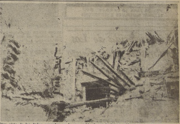
Otra vista de los daños causados en la casa ubicada en la intersección de las calles Acha y Ayacucho, de La Paz, por una bomba arrojada el domingo último por los aviones rebeldes. — (Foto del diario "La Razón", de La Paz, llegada por avión).
